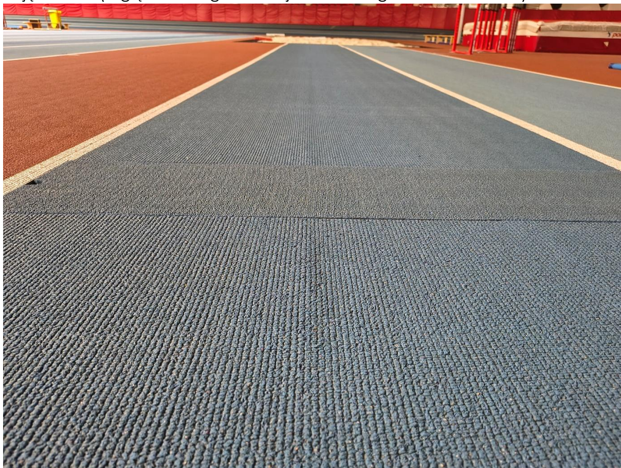
Zdjęcie nr 2 ( ugięcie dźwigara w rejonie rozbiegu do skoku w dal)
