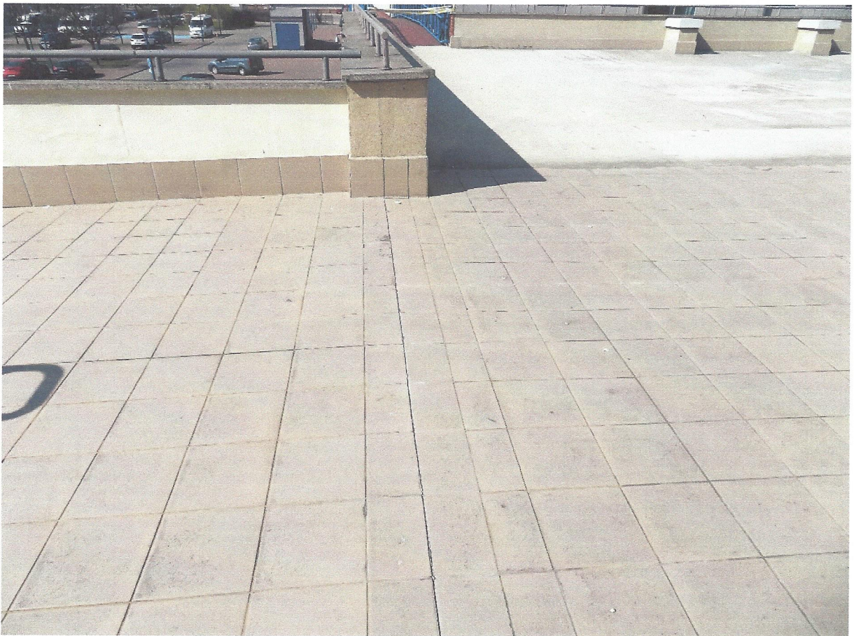
Dylatacja konstrukcyjna nie uszczelniona w murku i w posadzce tarasu.
