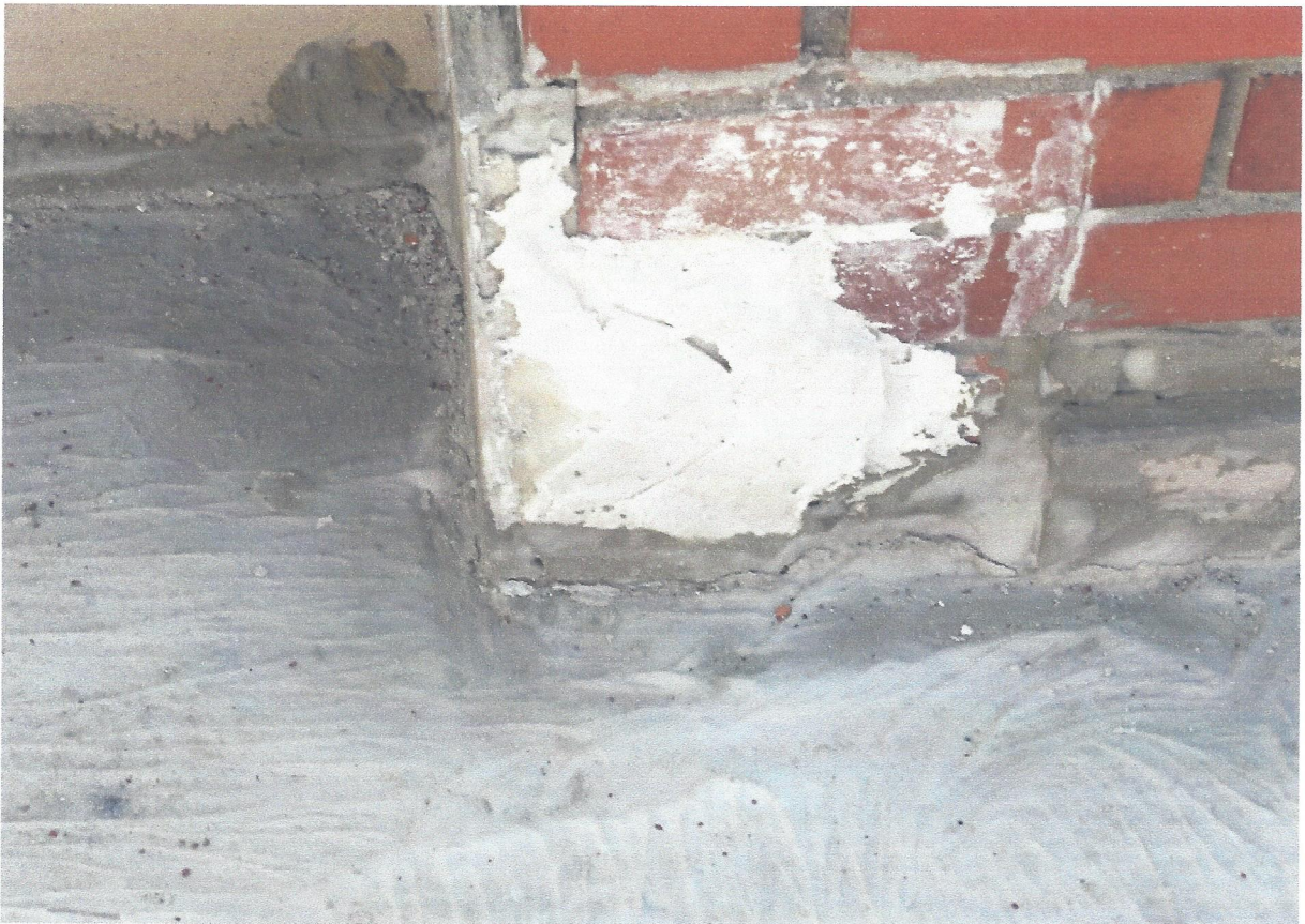
Dylatacja konstrukcyjna nie uszczelniona w murku i w posadzce tarasu.
