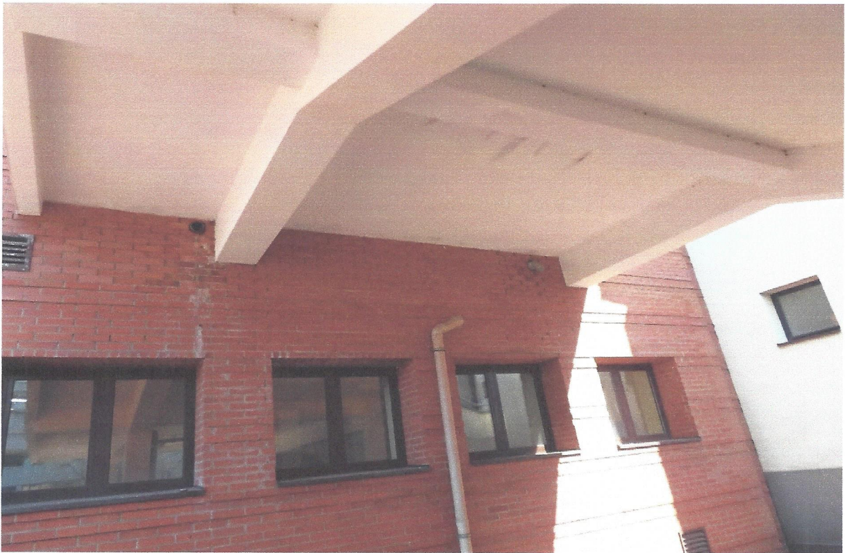
Widoczne rury wyprowadzające wodę z koryta zakrytego posadzką wykonanego na styku schodów z tarasem.
