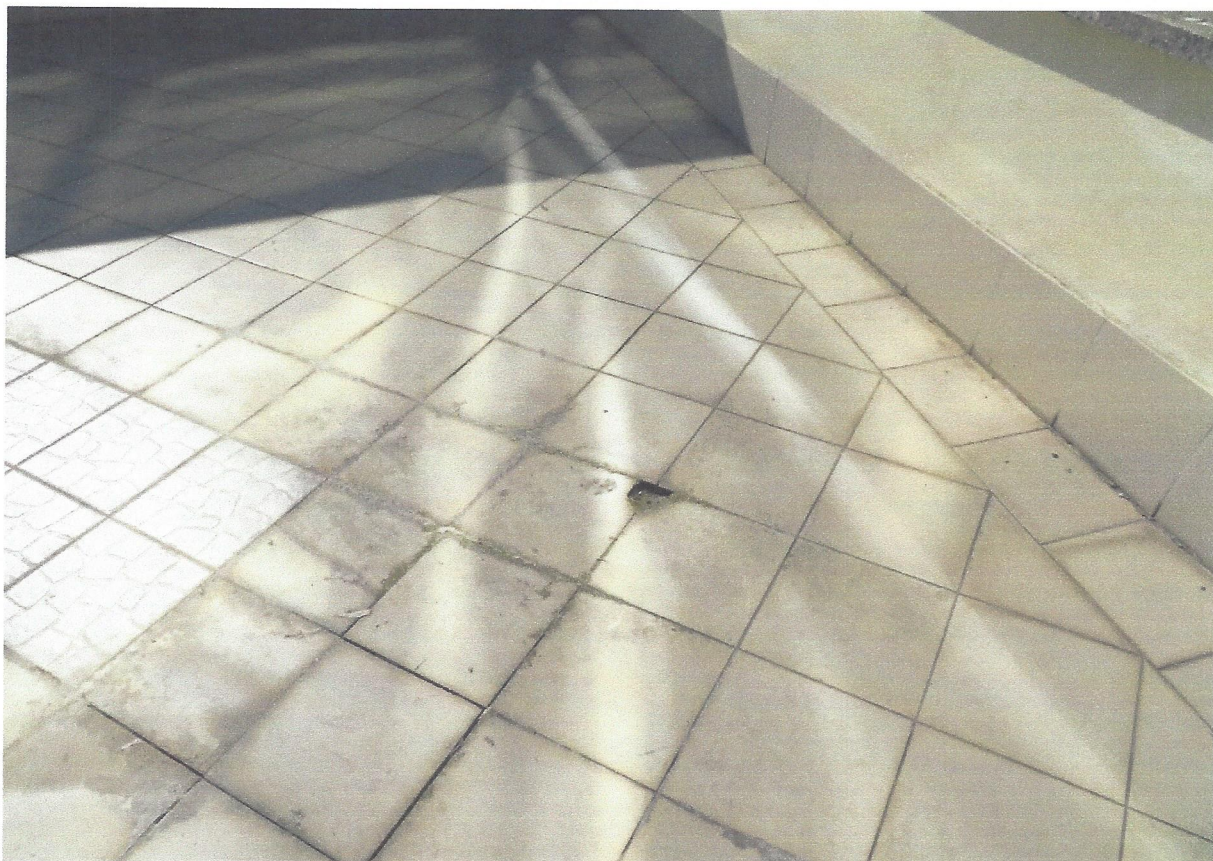
Przecieki przez czapki nakrywające murki ryzalitu.
