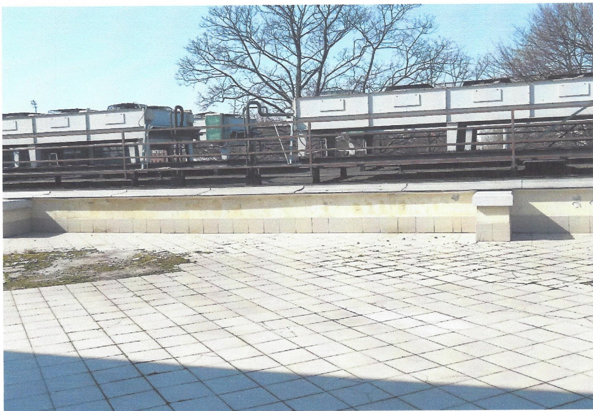
Nieszczelne obróbki blachatskie na murku po zachodniej stronie tarasu.
