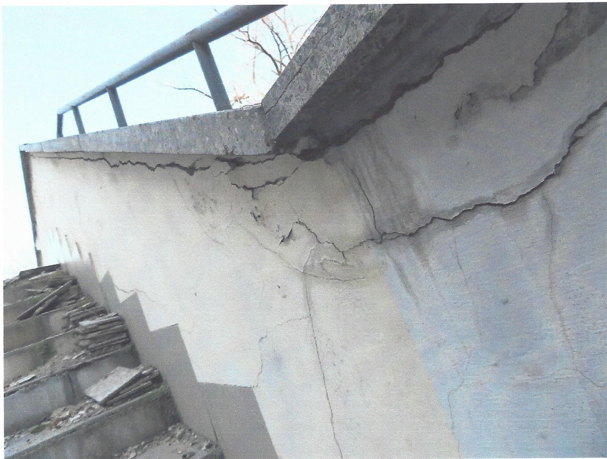
Nieszczelne obróbki blachatskie na murku po zachodniej stronie tarasu.
