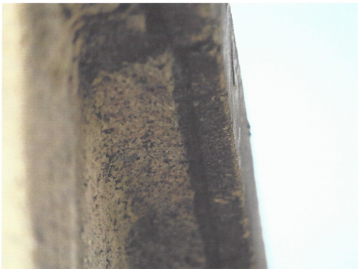
Uszkodzenia czapek lastrykowych na murkach tarasów i schodów.
