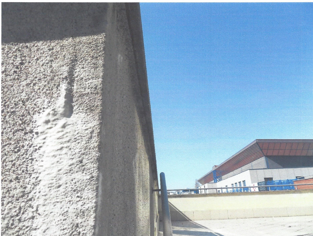
Uszkodzenia czapek lastrykowych na murkach tarasów i schodów.
