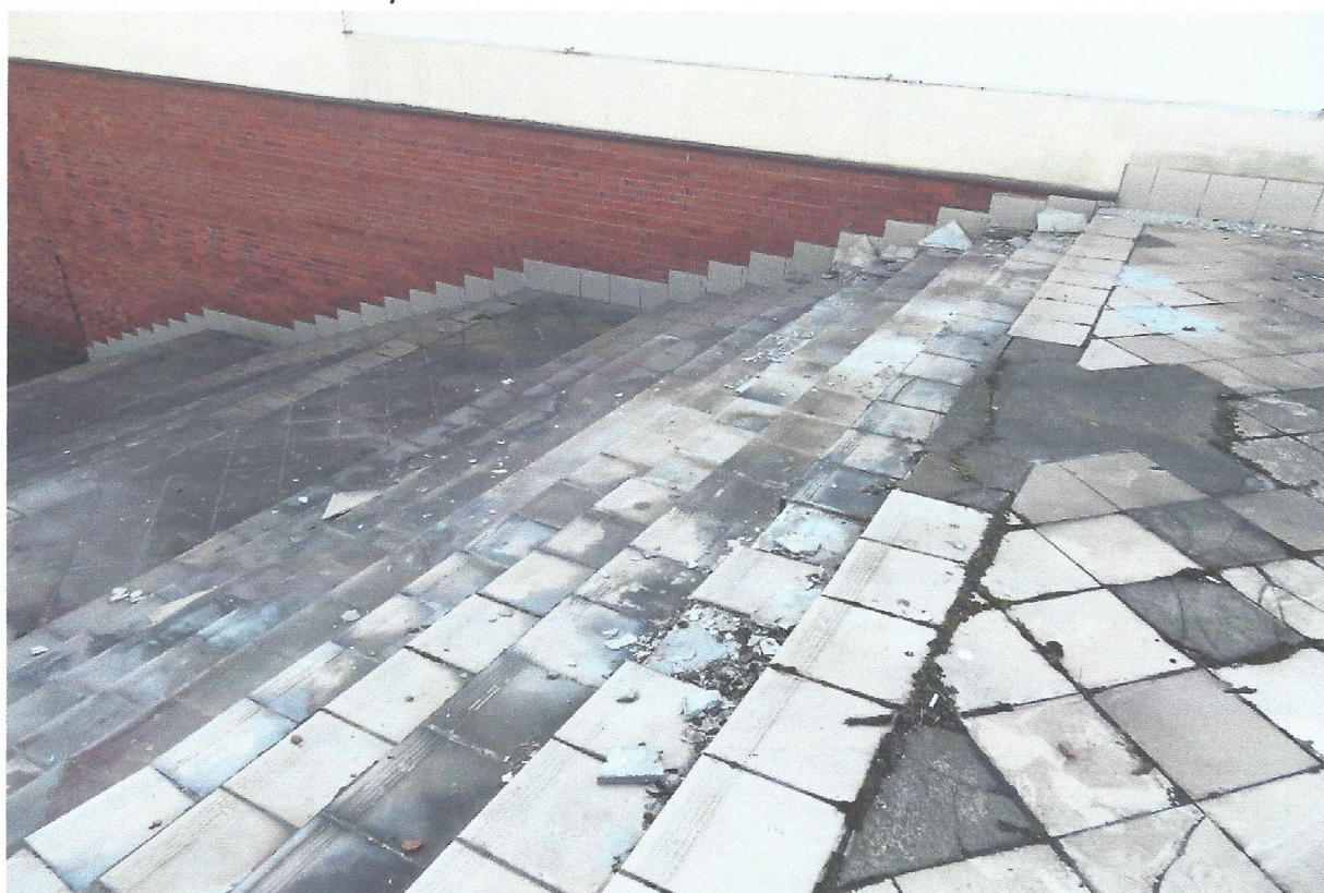
Nawierzchnia schodów w złym stanie.
