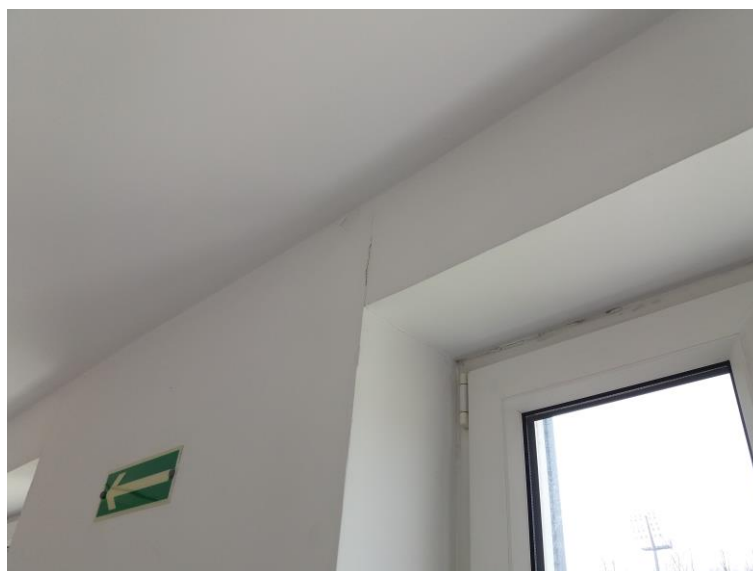
FOT. 16 ZARYSOWANIE OBUDOWY ŚCIANY W OSI 4 I 5 W STREFACH NADPROŻOWYCH
