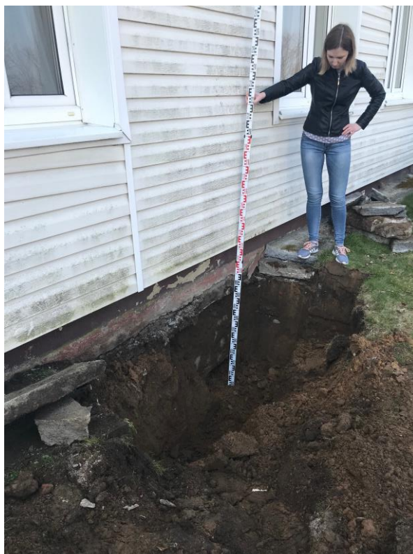
FOT. 1 POMIAR POZIOMU POSADOWIENIA FUNDAMENTÓW
