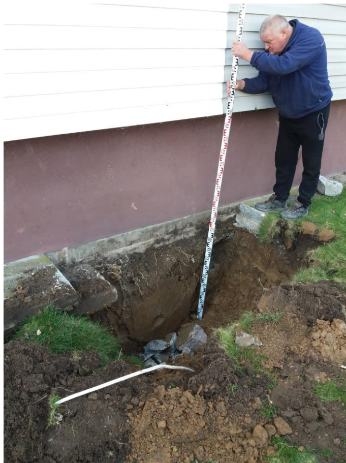
FOT. 1 POMIAR POZIOMU POSADOWIENIA FUNDAMENTÓW
