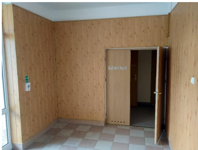
Ściany holu hali SW pokryte panelami MDF.
