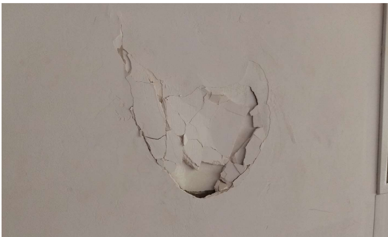
Foto: uszkodzenie ściany g-k.
