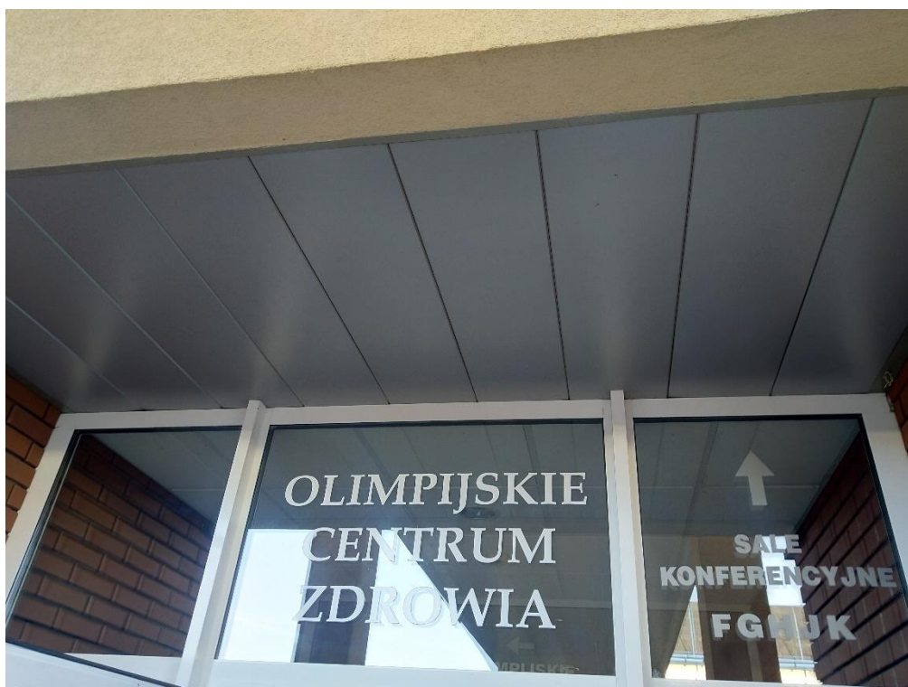
Metalowy sufit od zewnątrz
