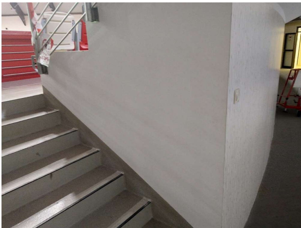
Montaż wykładziny Tarkett na ściankach przy schodach
