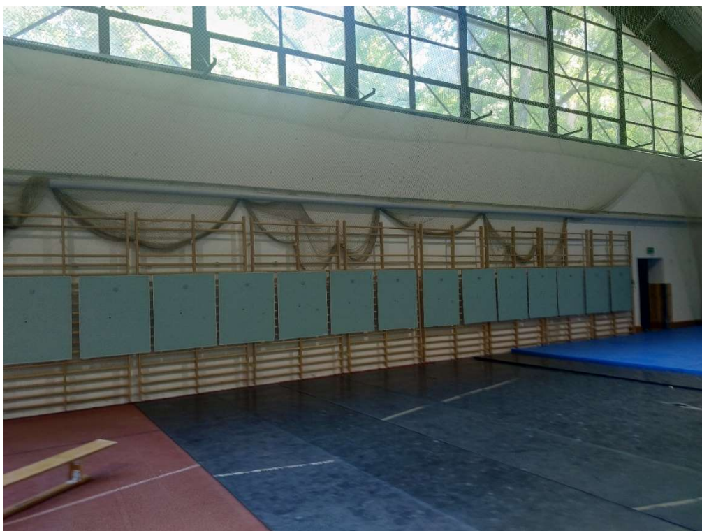
Montaż okładzin z płyty aluminiowej i płyty osb
