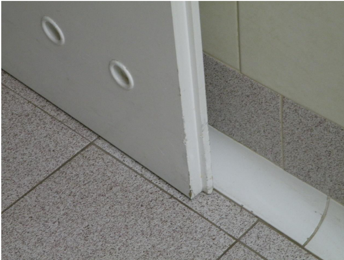
Uszkodzenia drzwi
