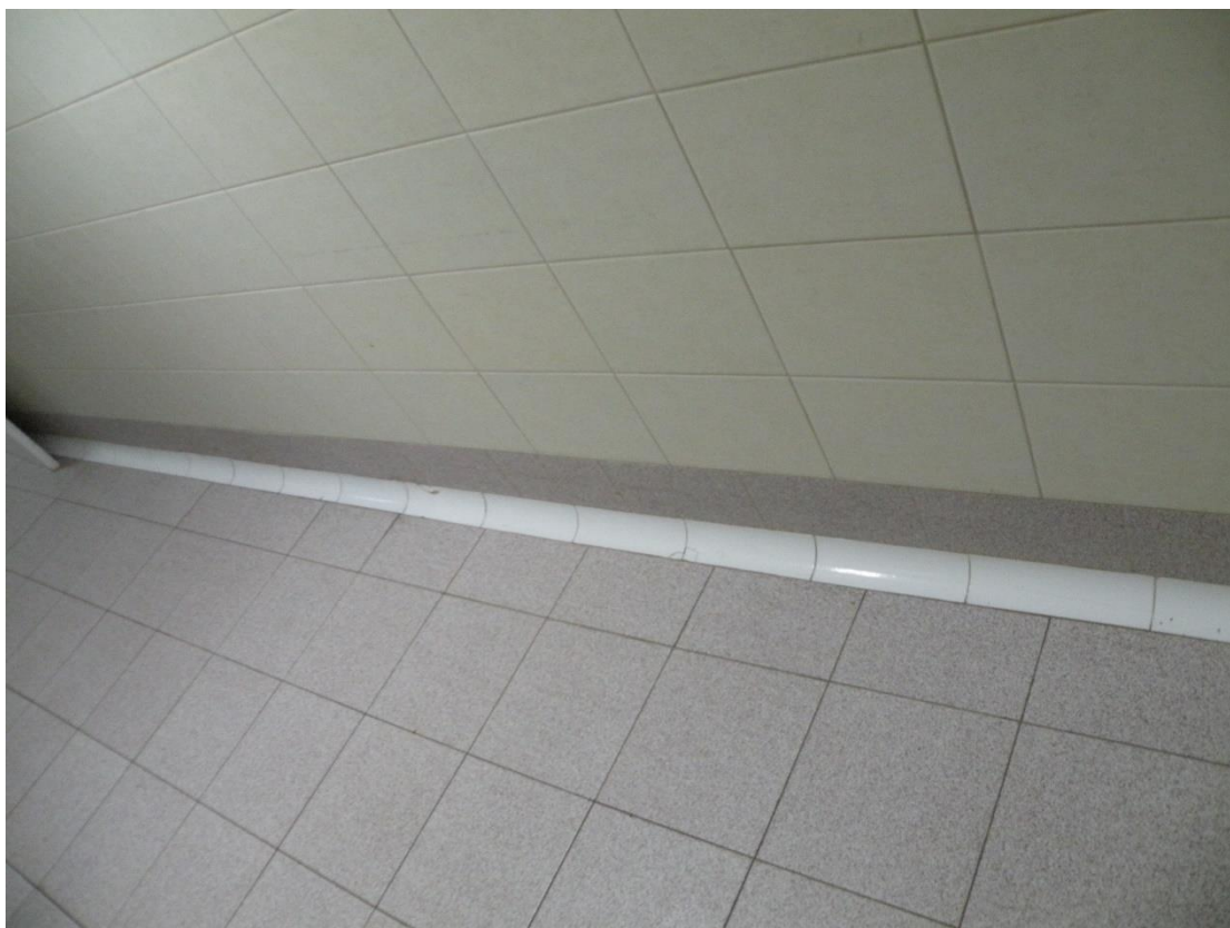
Uszkodzenia wyobleń
