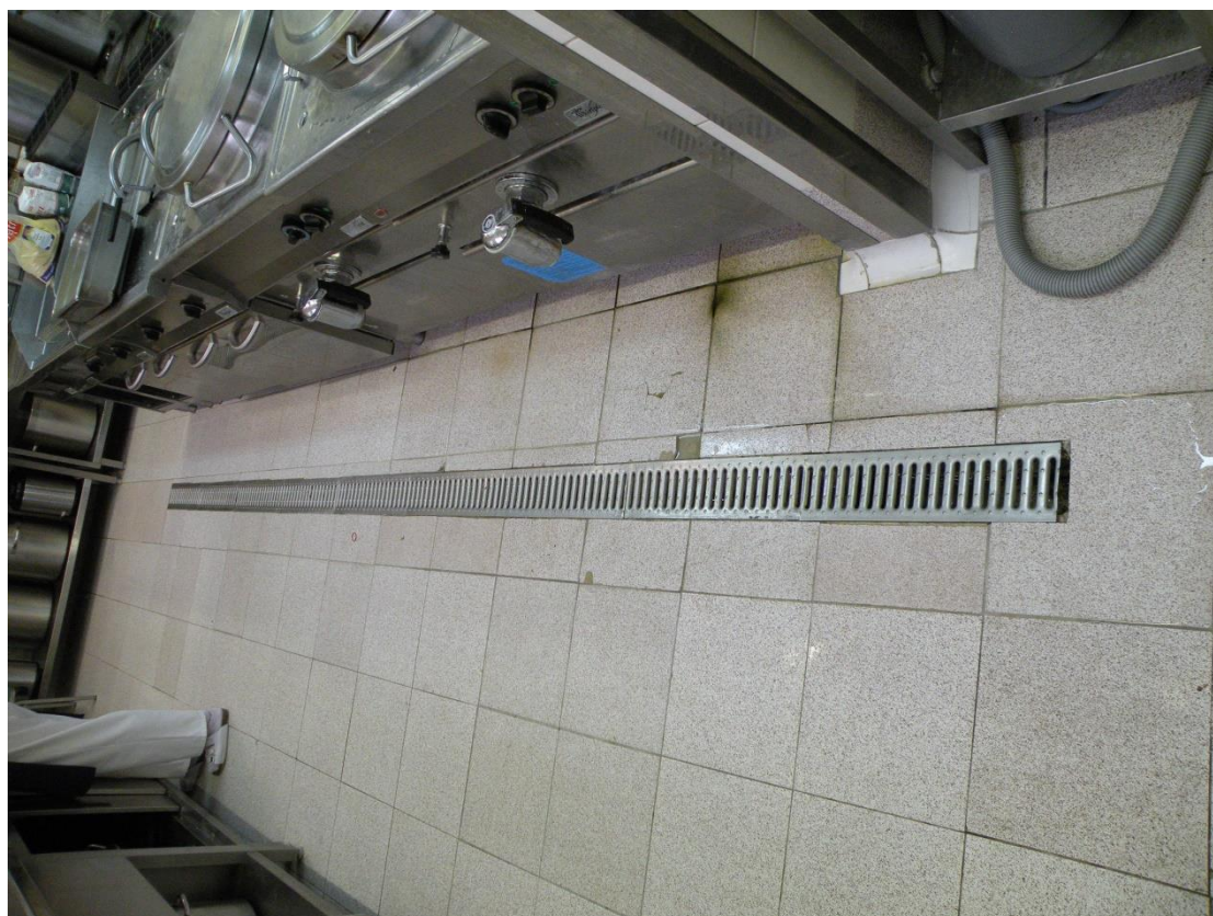
Odwodnienie liniowe w „nowej” kuchni
