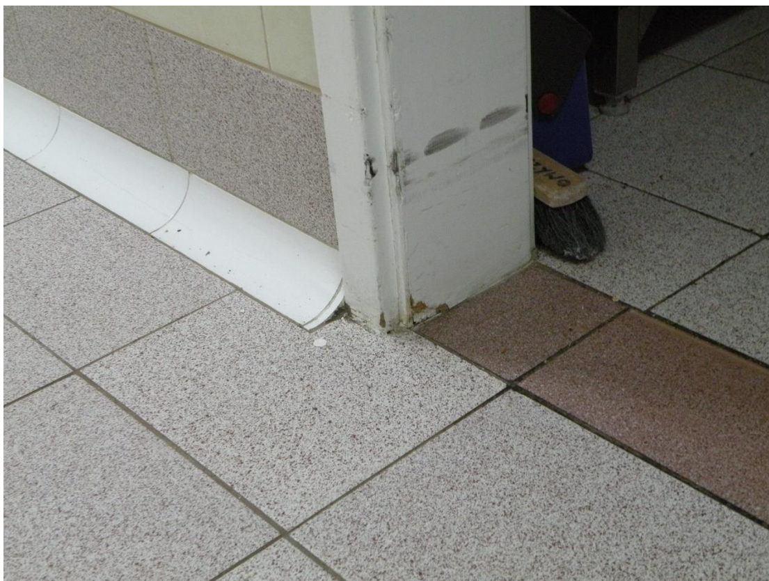
Uszkodzenia drzwi
