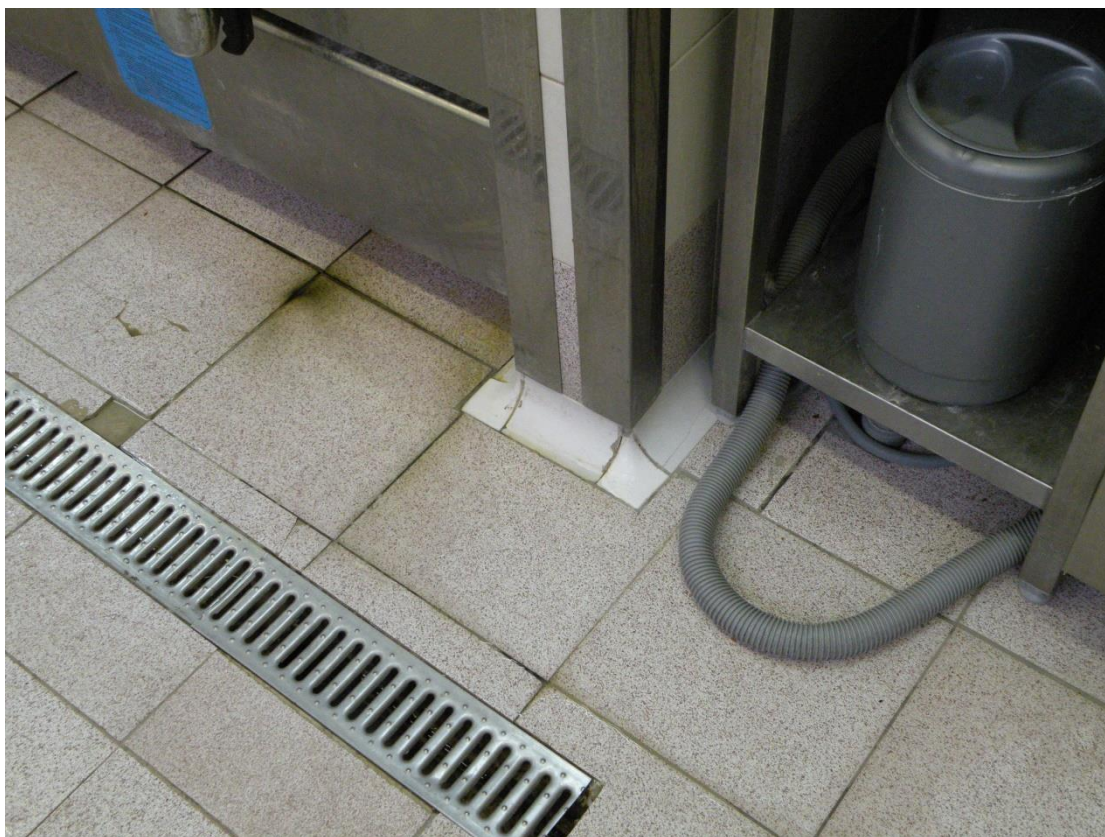
Odwodnienie liniowe i płytki wyobłeń w „nowej” kuchni
