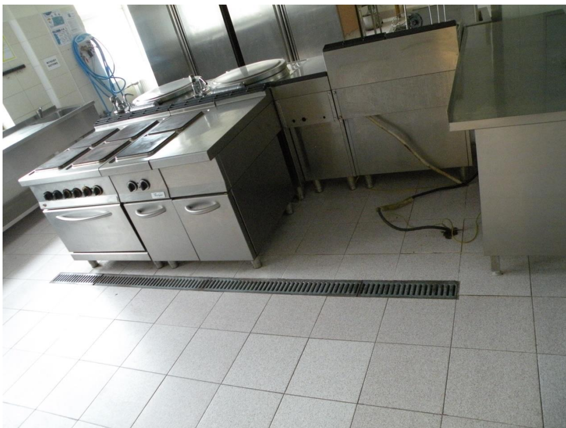
Odwodnienie liniowe i urządzenia do wymiany w kuchni „starej”
