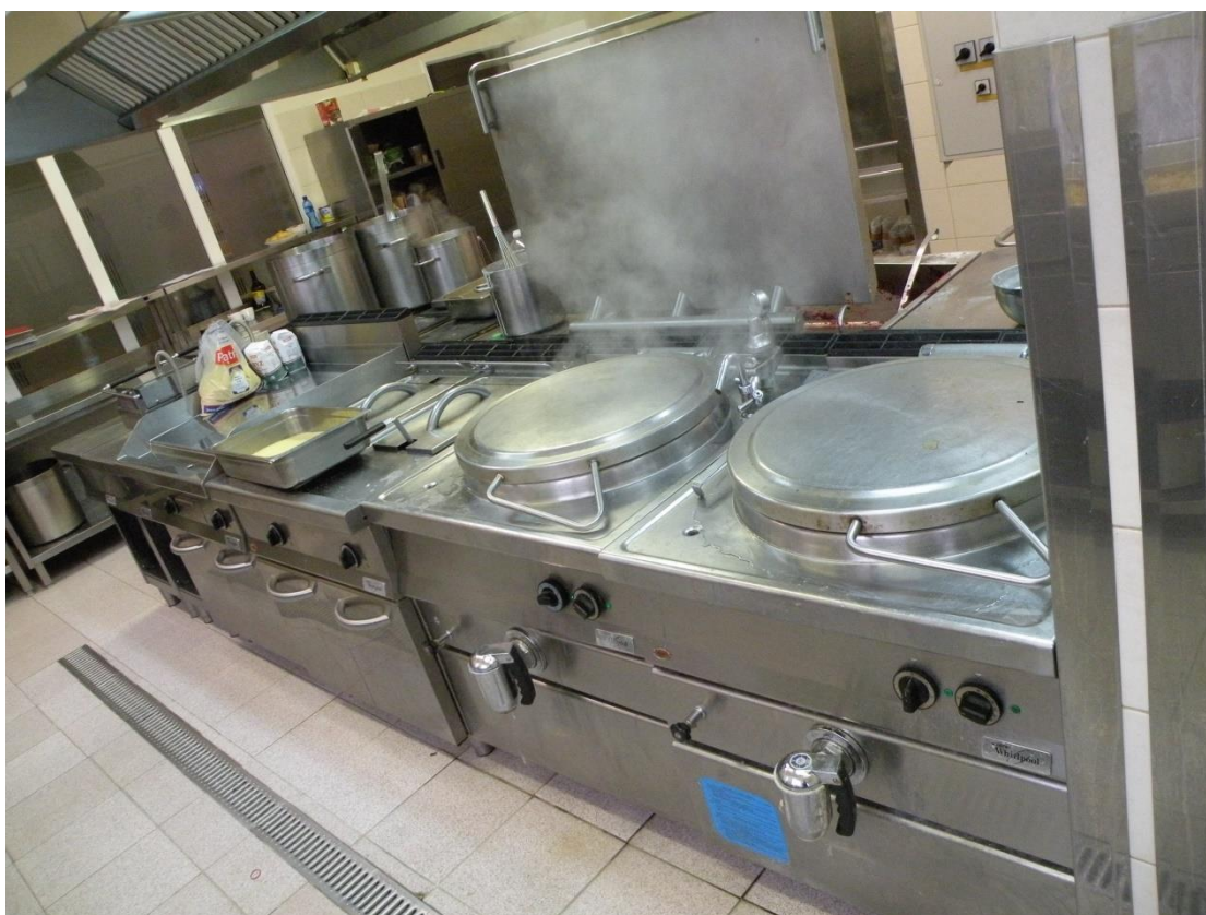
Odwodnienie liniowe i urządzenia do wymiany w „nowej” kuchni
