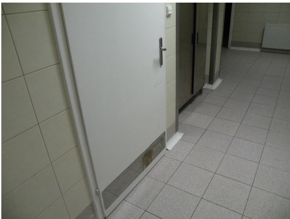
Uszkodzenia drzwi
