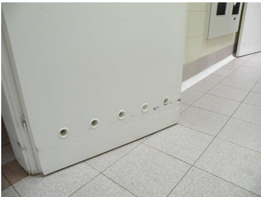
Uszkodzenia drzwi
