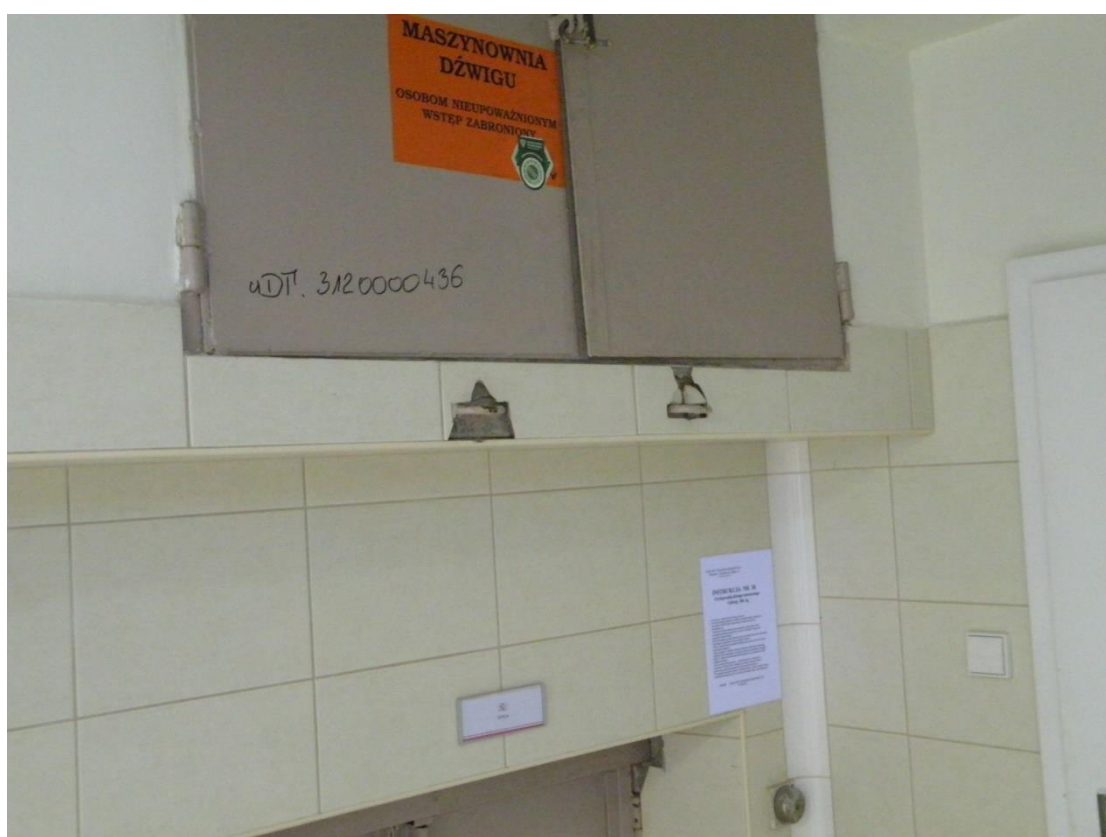
Uszkodzenia okładzin ściennych
