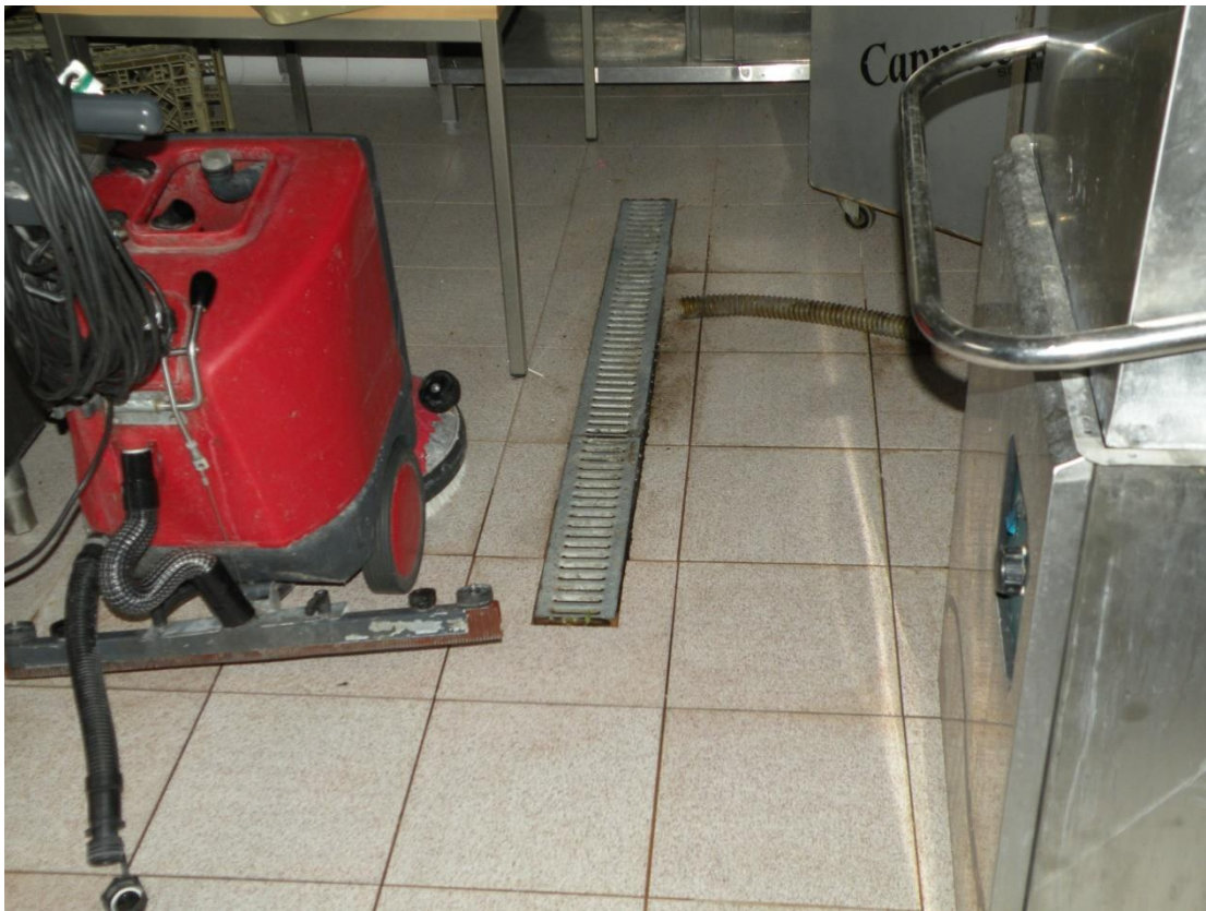
Odwodnienie liniowe w „starej” zmywalni
