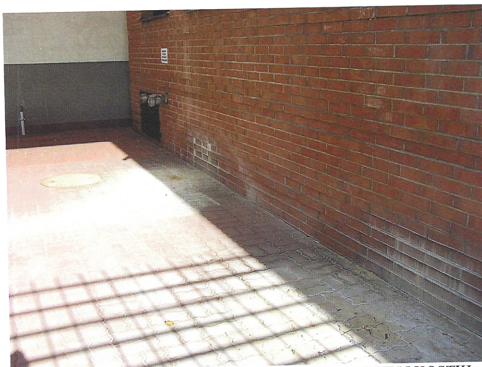
FOT.7. PRZEBARWIENIA OKŁADZINY KLINKIEROWEJ I KOSTKI BETONOWEJ SPOWODOWANE WYCIEKAJĄCĄ WODĄ Z ŻYGACZY.
