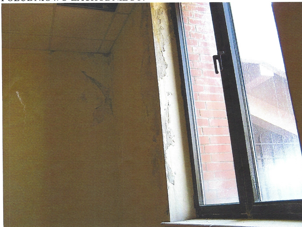
FOT. 34 ZACIEKI NA ŚCIANACH, NA GLIFACH I NA SUFICIE.
