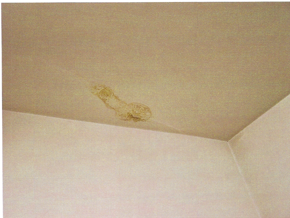
FOT. 39. ZACIEKI NA SUFICIE.
