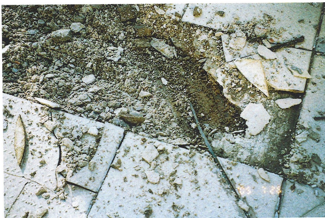
FOT.23. ODKRYWKA NR 3. ZNISZCZONA STRUKTURA BETONU WYRÓWNAWCZEGO W MIEJSCU DYLATACJI.
