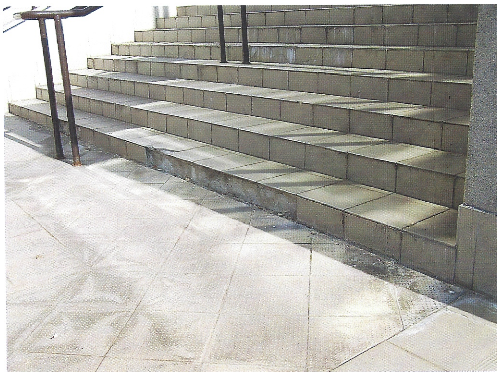
FOT.4 USZKODZENIA SCHODÓW – UBYTKI PŁYTEK GRESIOWYCH WYCIEKI SOLNE.
