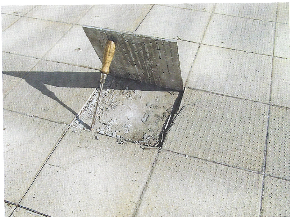
FOT.10. SZCZĄTKOWE ILOŚCI KLEJU POD PŁYTKĄ GRESOWĄ
