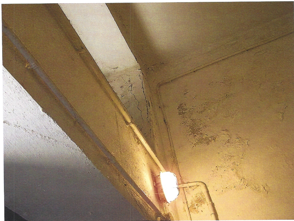
FOT. 45 ZACIEKI NA ŚCIANIE WEWNĘTRZNEJ I ZEWNĘTRZNEJ W TRANSFORMATOROWNI.
