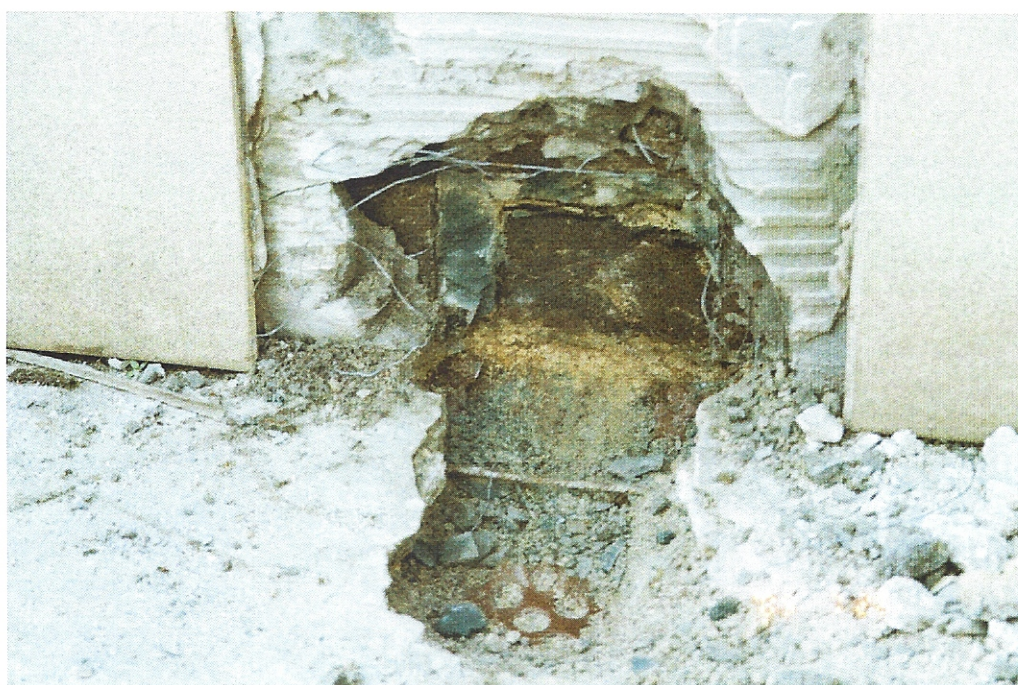
FOT. 32. ODKRYWKA NR 4. WIDOCZNA FOLIA KUBELKOWA POD SZLICHTĄ ORAZ IZOLACJA PAPOWA WYWINIĘTA NA ŚCIANĘ.
