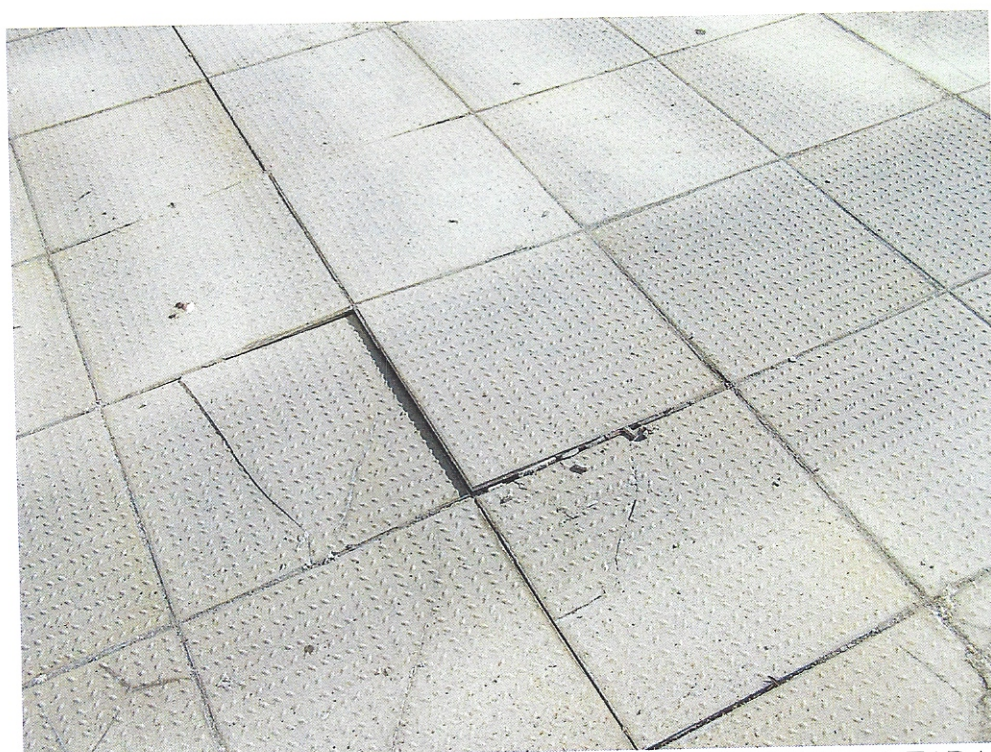
FOT.8. SPĘKANIA I ODSPOJENIA PŁYTEK GRESOWYCH NA TARASIE RYZALITU.
