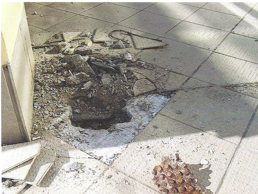
FOT. 16 ODKRYWKA NR 1 NA ZŁĄCZU DYLATACYJNYM.
