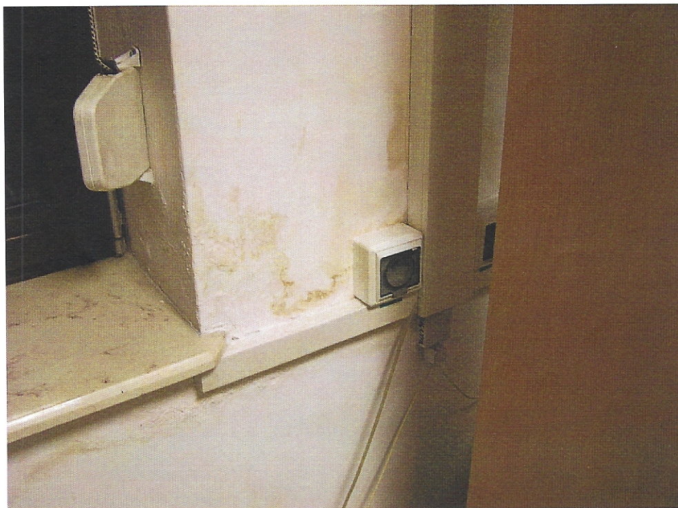
FOT. 40. ŚLADY PO ZACIEKACH NA FILARZE MIĘDZYOKIENNYM.
