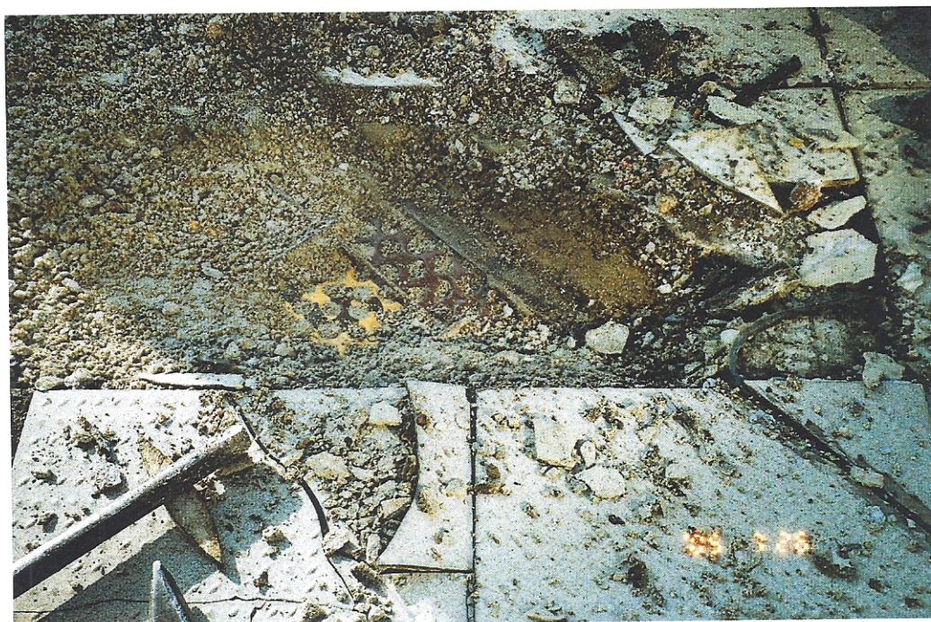
FOT. 24. ODKRYWKA NR3. WIDOCZNA FOLIA KUBEŁKOWA ORAZ KRATKA DRENAŻOWA.
