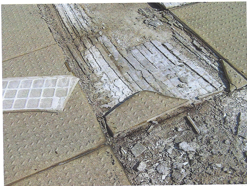
FOT.11. ODPARZONE I POPEKANE PŁYTKI GRESOWE.. ZNISZCZONA ZAPRAWA KLEJOWA.
