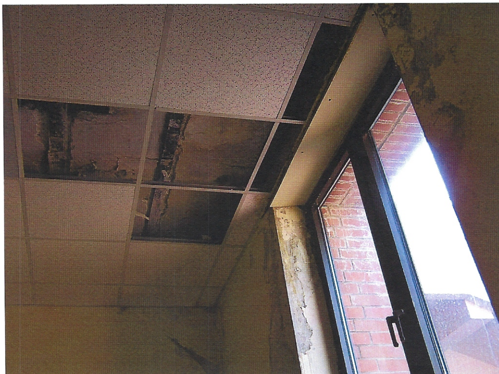
FOT. 33 ZACIEKI NA STROPIE, NA SUFITACH PODWIESZANYCH ORAZ NA OŚCIEŻACH OKIENNYCH W SALI RYZALITU POŁUDNIOWO-ZACHODNIEGO.
