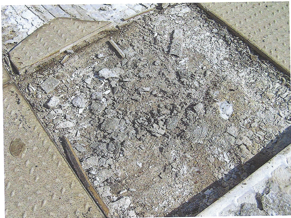
FOT.12. ZNISZCZONA ZAPRAWA KLEJOWA.
