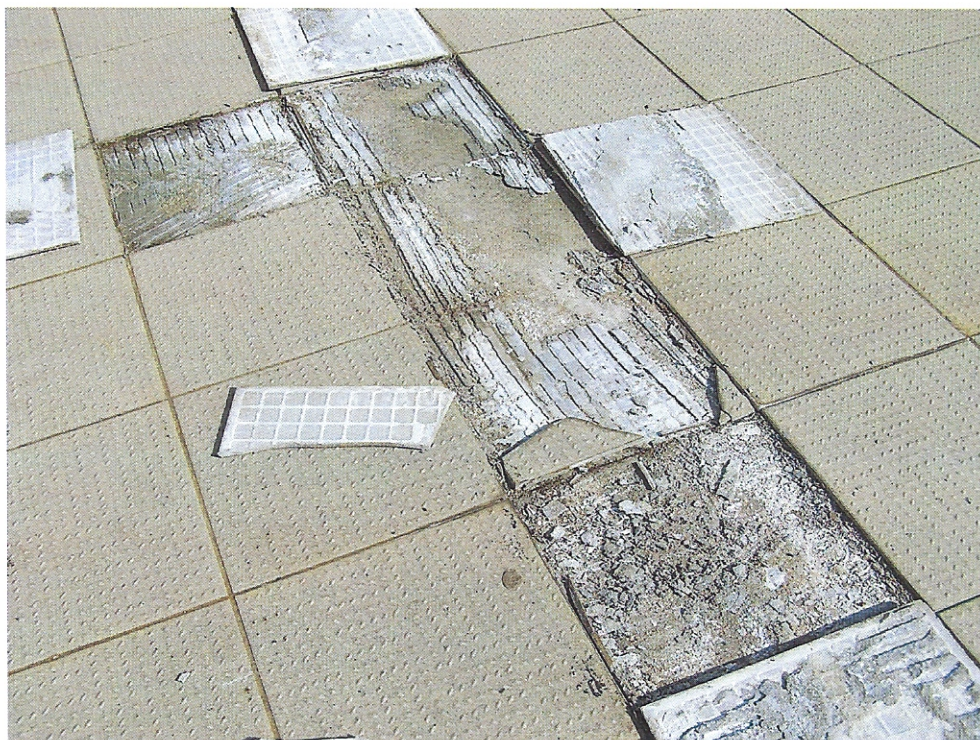
FOT.13. ODPARZONE PŁYTKI GRESOWE
