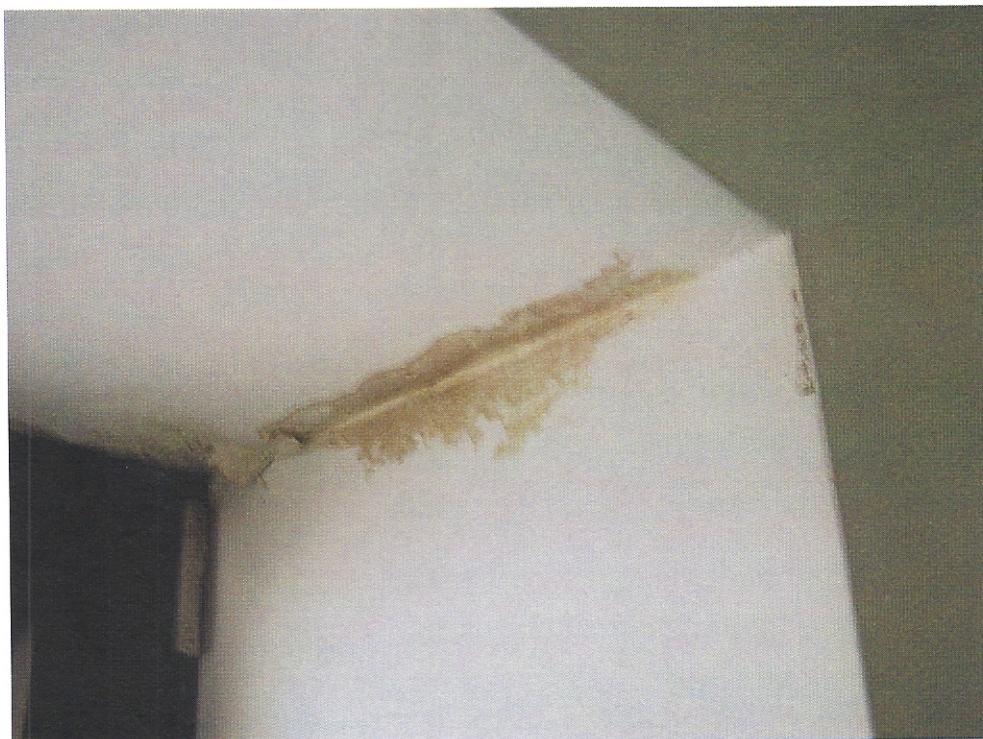
FOT. 36 ZACIEKI W NAROŻACH POMIESZCZENIA W RYZALICIE POŁUDNIOWO-WSCHODNIM.
