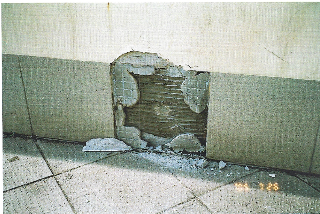
FOT. 29. ODKRYWKA NR 4. USUNIĘTA PŁYTKA GRESOWA COKŁOWA.
