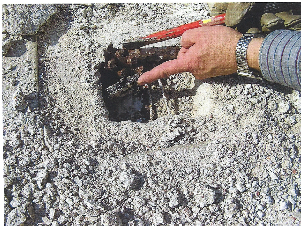
FOT. 21 ODKRYWKA NR 2 WIDOCZNA FOLIA KUBEŁKOWA ORAZ WARSTWY IZOLACYJNE Z PAPY.
