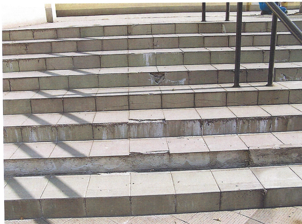
FOT.5. USZKODZENIA SCHODÓW – UBYTKI PŁYTEK GRESIOWYCH WYCIEKI SOLNE.
