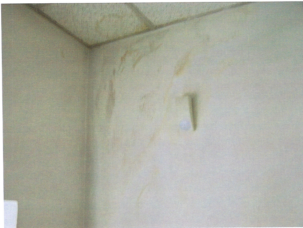
FOT. 37. ZACIEKI NA ŚCIANACH I NA SUFICIE.
