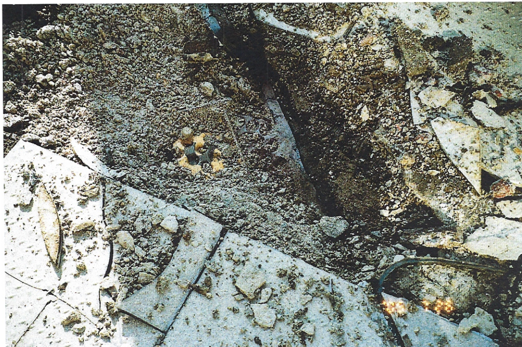
FOT. 25. ODKRYWKA NR 3. KRATKA DRENAŻOWA NAD RYNIENKĄ ODPLYWOWĄ.
