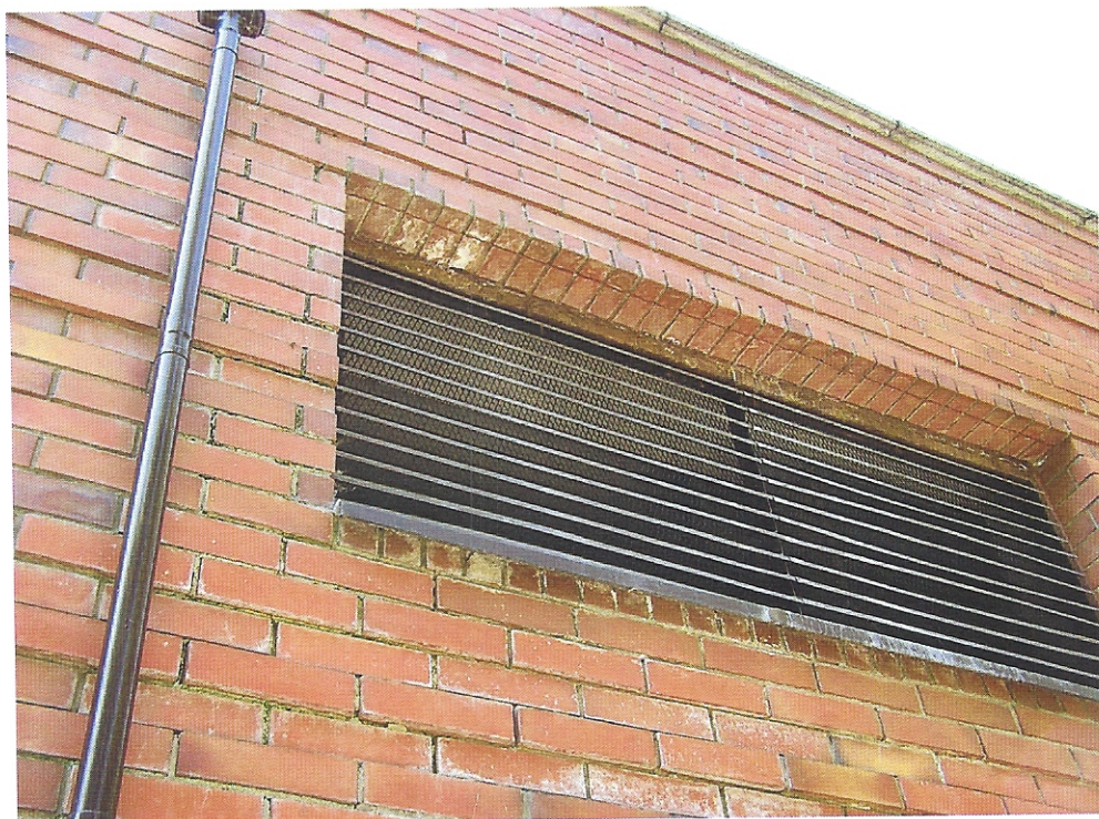
FOT. 46. ŚLADY PO ZACIEKACH NAD OKNEM TRANSFORMATOROWNI W RYZALICIE PÓŁNOCNO-ZACHODNIM.
