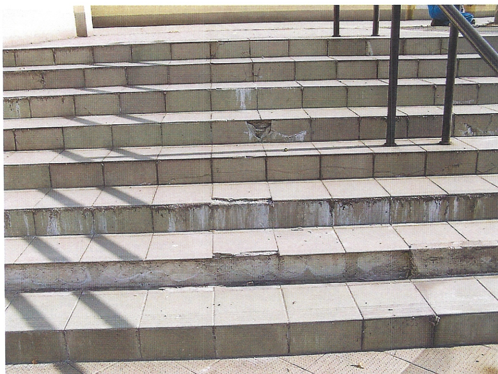
FOT.3. USZKODZENIA SCHODÓW – UBYTKI PŁYTEK GRESIOWYCH WYCIEKI SOLNE.
