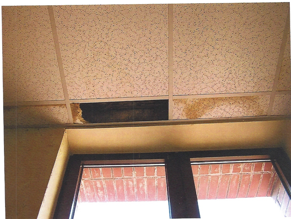
FOT. 43. ZACIEKI NA SUFICIE W SALI GIMNASTYCZNEJ W RYZALICIE POŁUDNIOWO-ZACHODNIM.
