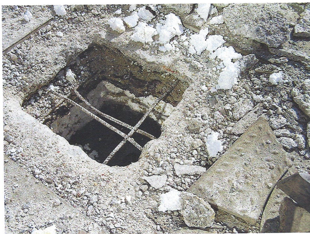
FOT. 22. ODKRYWKA NR 2. WIDOCZNA WARSTWA STYROPIANU. STWIERDZONO, ŻE STYROPIAN BYŁ SUCHY.
