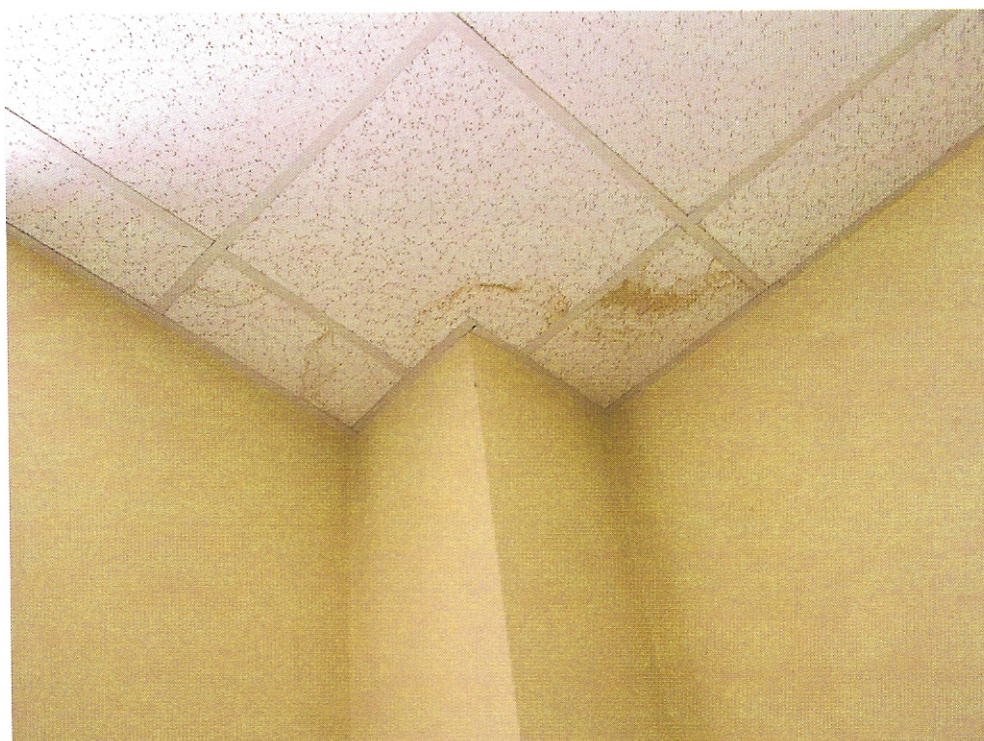
FOT. 42. ZACIEKI NA SUFICIE W SALI GIMNASTYCZNEJ W RYZALICIE POŁUDNIOWO-ZACHODNIM.
