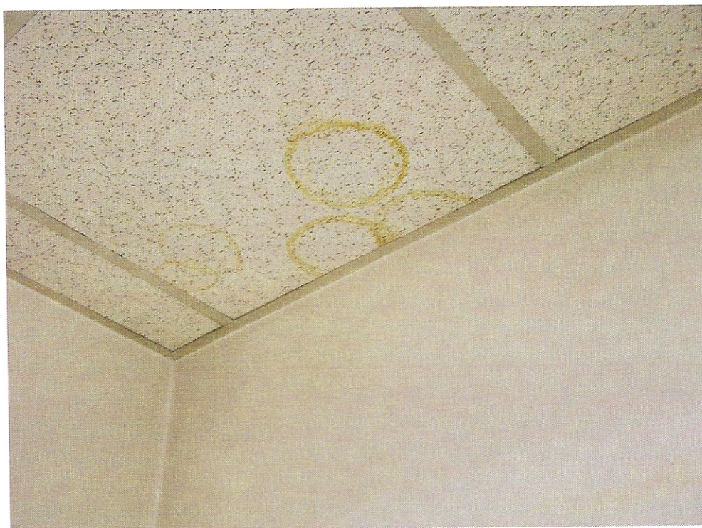
FOT. 38. ZACIEKI NA SUFICIE.
