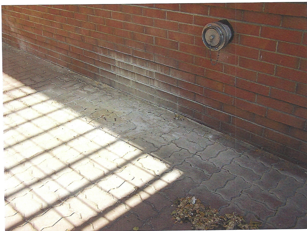
FOT.6. PRZEBARWIENIA OKŁADZINY KLINKIEROWEJ I KOSTKI BETONOWEJ SPOWODOWANE WYCIEKAJĄCĄ WODĄ Z ŻYGACZY.
