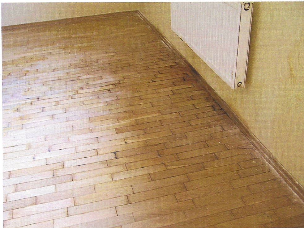
FOT. 35. ZNISZCZONA PODŁOGA W SALI FGIMNASTYCZNEJ W RYZALICIE POŁUDNIOWO-ZACHODNIM.
