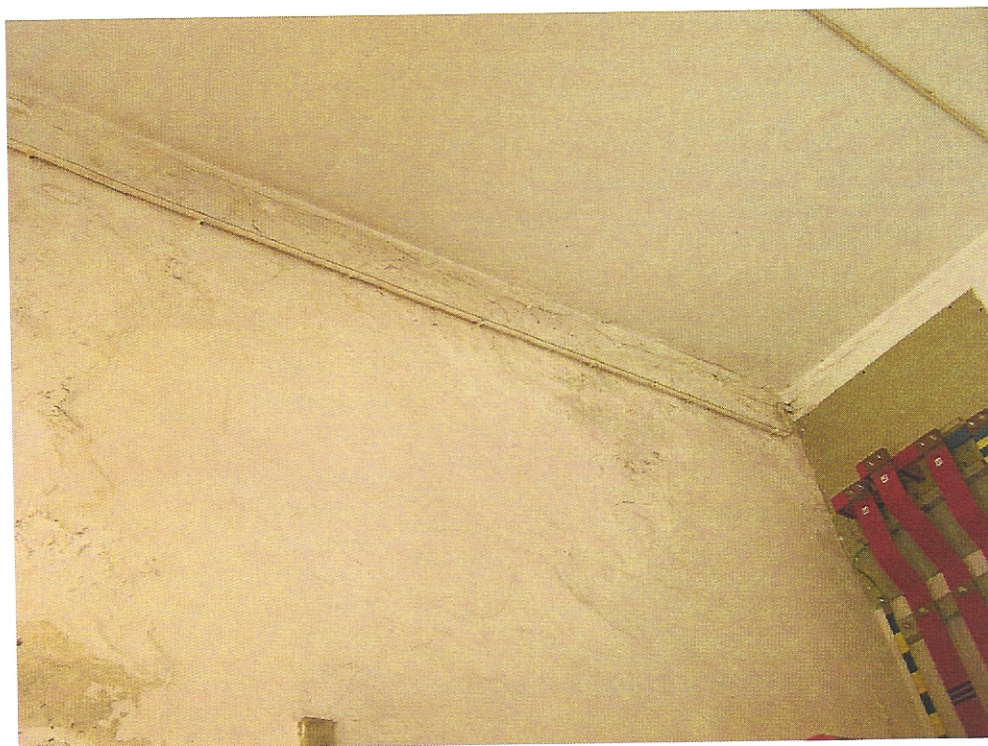
FOT. 44. ZACIEKI NA ŚCIANIE W TRANSFORMATOROWNI W RYZALICIE PÓŁNOCNO-ZACHODNIM.
