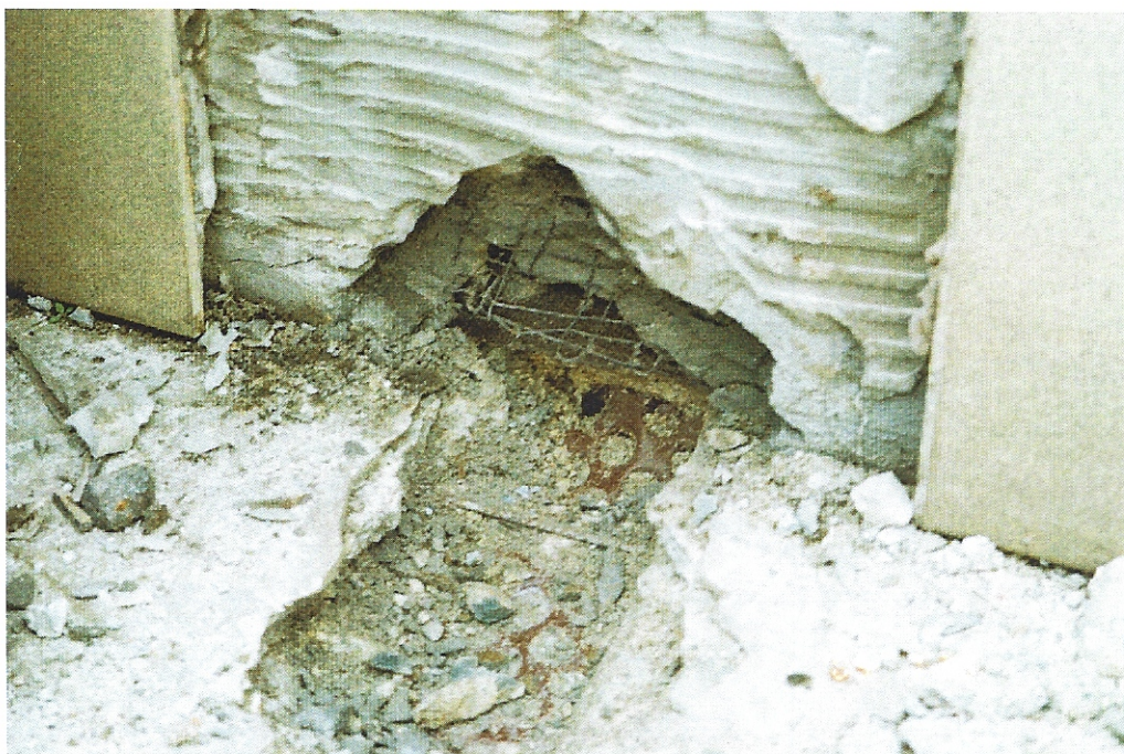
FOT. 31. ODKRYWKA NR4. ROZKUCIE SZLICHTY ORAZ WYPRAWY COKOŁOWEJ.
