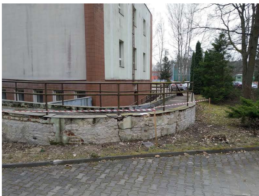
Zewnętrzny murek oporowy rampy
